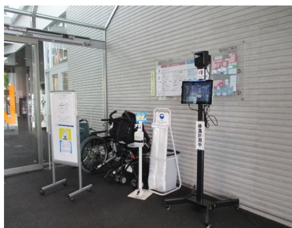
メインエントランス風除室のサーモグラフィー
